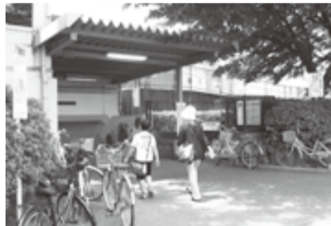
鷹の台駅地下自由通路の入口 (中央公園側)
