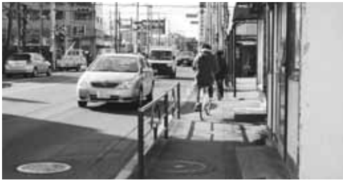
歩道等の整備が予定されている青梅街道(青梅街道駅東側)
