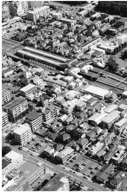
10月から測量が始まる 小川駅西口再開発事業
