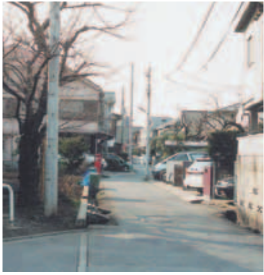
大雨により冠水したことがある道路(武蔵野団地・鈴木町一丁目)
