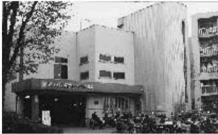
譲渡された花小金井駅南自転車駐車場
