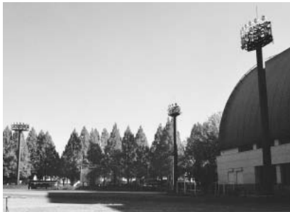
中央公園グラウンドナイター設備
