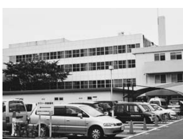
公立昭和病院東病棟
