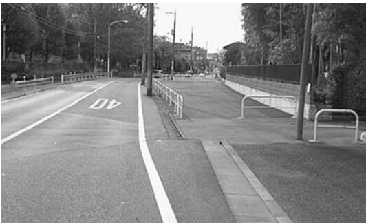
▲東京街道の拡幅用地部分
