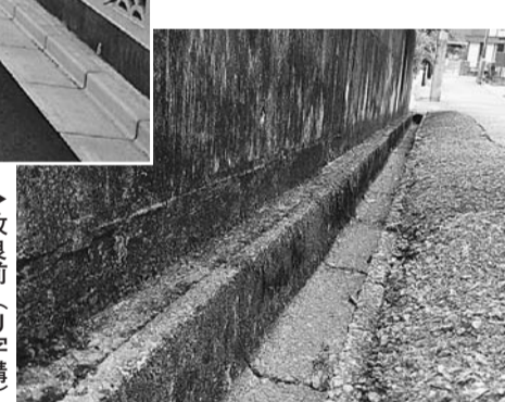
道路の整備にあわせて進められている武蔵野団地の雨水排水整備
