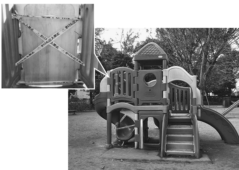
破損部を閉鎖した東部公園の遊具
