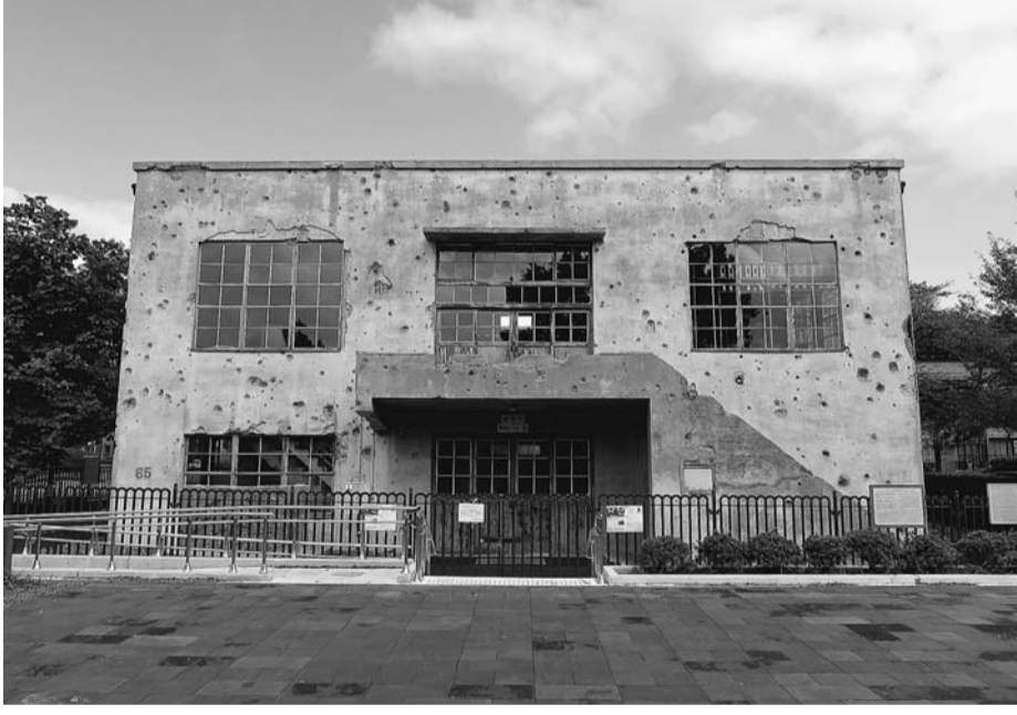
東大和市の震災遺構、旧日立航空機株式会社変電所
