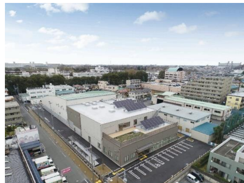
リサイクルセンター全景
