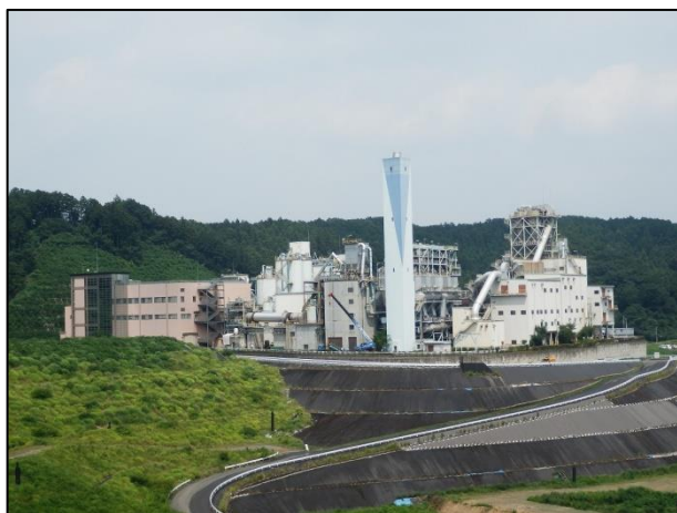
エコセメント化施設の全景(平成 30 年(2018)7 月撮影)
