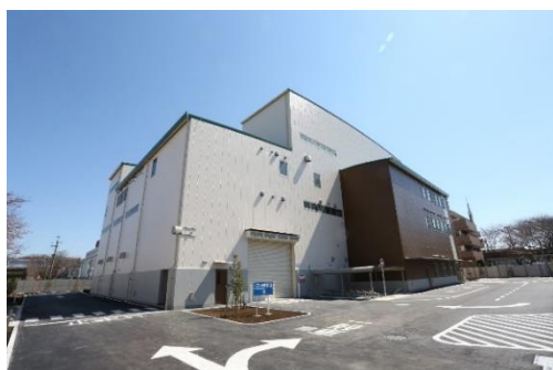
資源物中間処理施設の外観
