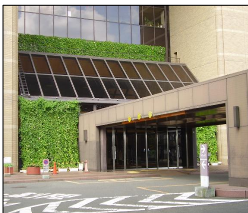
市役所正面玄関の緑のカーテン
