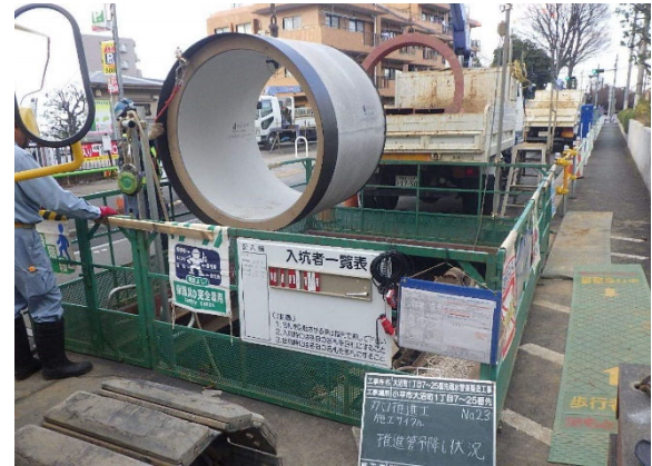
雨水管きょ整備
