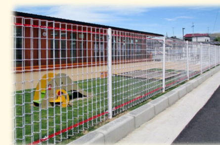
フェンス(子ども遊具エリア周り)
