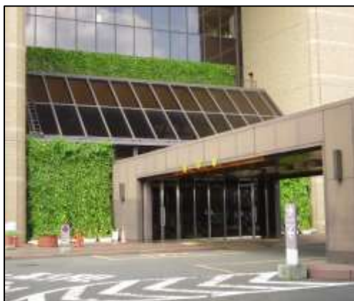
市役所正面玄関の緑のカーテン
