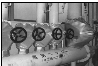
図1.9 蒸気ヘッド部バルブの保温施工
