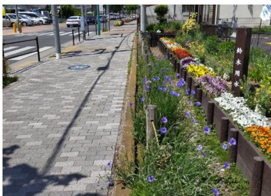
擬木を使用した護岸①
