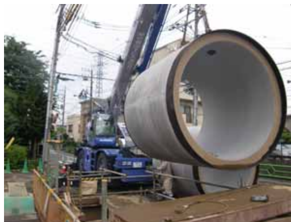
写真5-6 雨水管きょの整備状況
