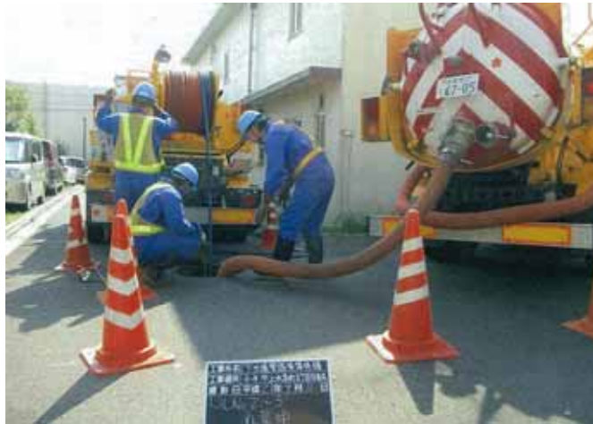
写真 5 - 5 管きよの清掃状況
