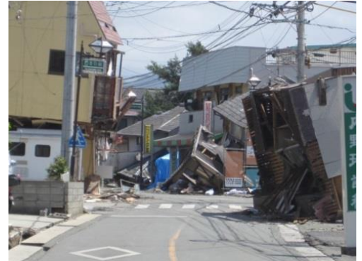
地震で損壊した建物
