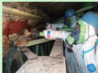
吹付け石綿の除去作業の様子
