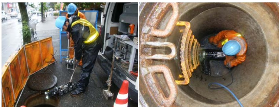
写真 3-3 管きょ内調査の状況
