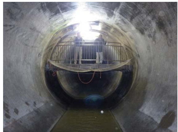
写真 3-5 ふれあい下水道館（管内の様子）
