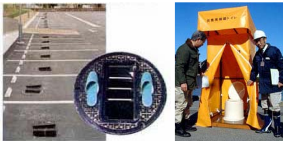
写真 3-2 マンホールトイレの一例
