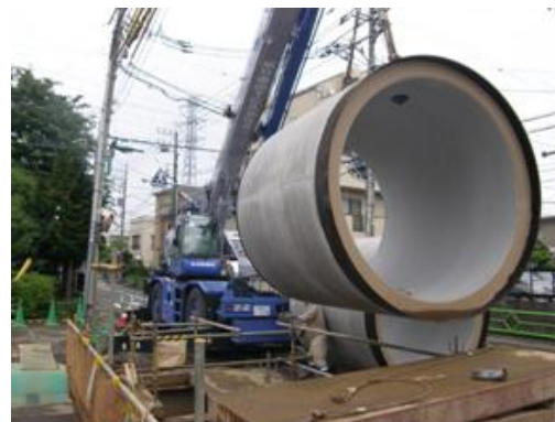
雨水管きよ整備
