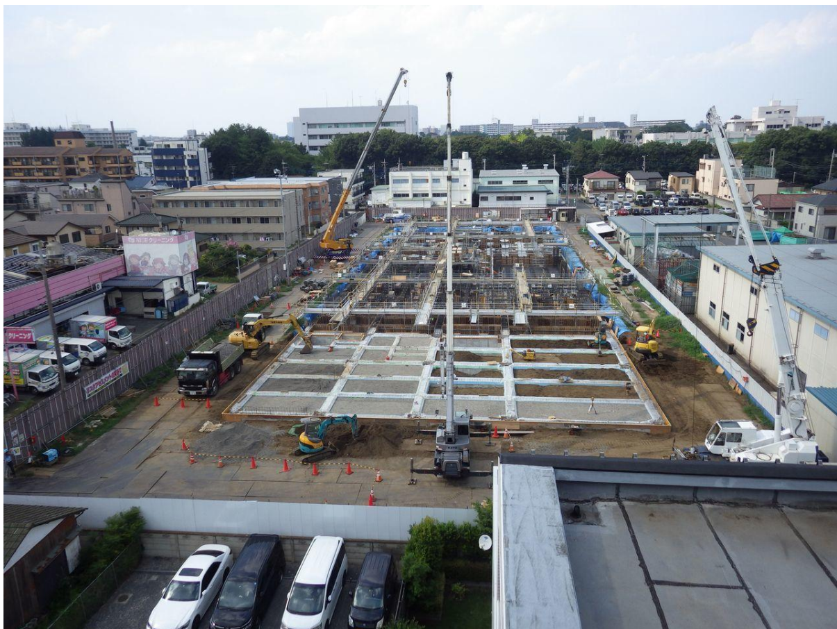
・基礎、土工事（平成30年8月3日時点）
