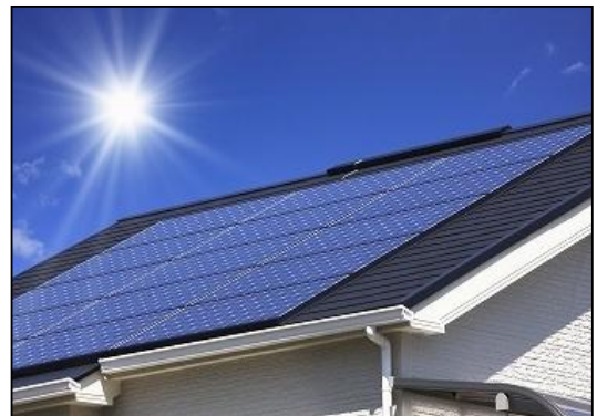
太陽光発電設備
