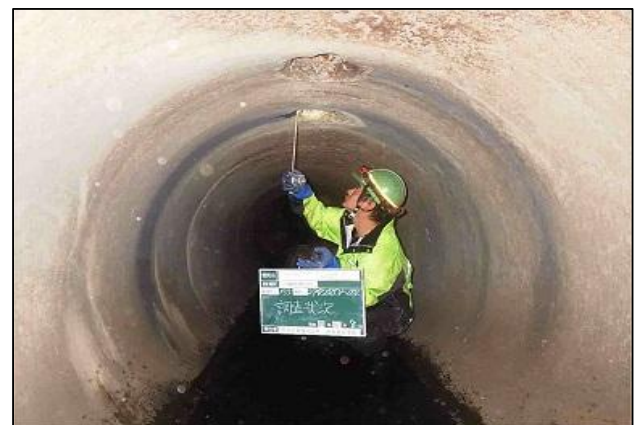
下水道管さよの調査の様子
