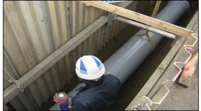
雨水管さよ築造工事の様子
