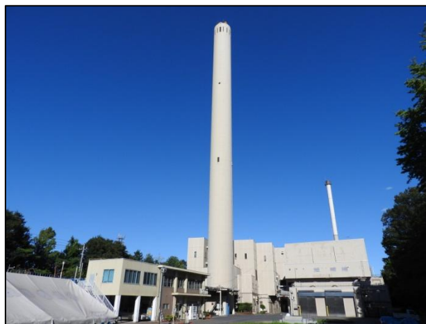
小平・村山・大和衛生組合の外観
