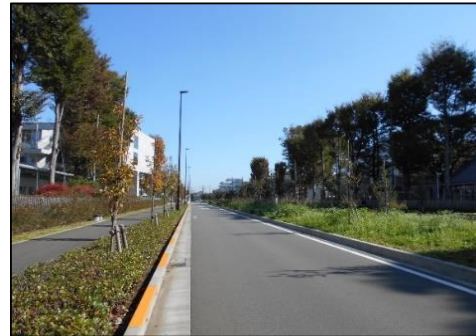
無電柱化実施路線 （武蔵野美術大学前(市道第B-222号線)）
