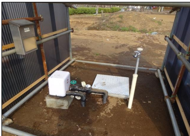
平成29年度に設置した防災兼用農業用井戸
