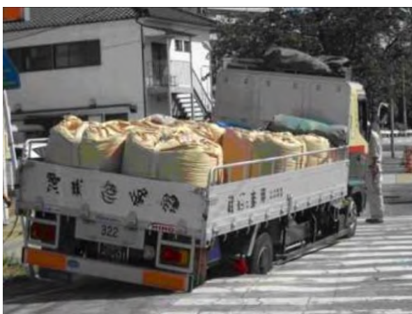
写真 1-1 管路施設に起因した道路陥没の状況
