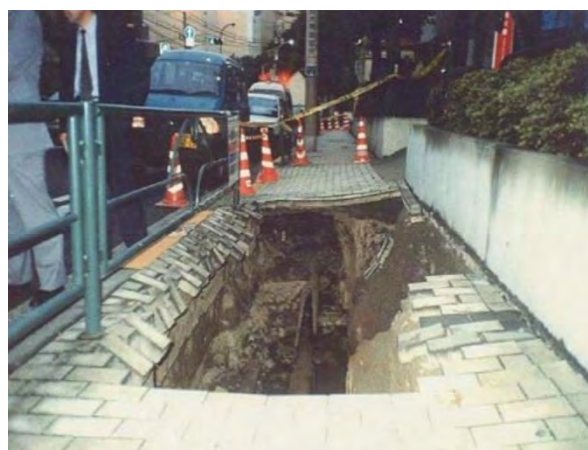
写真 1-1 管路施設に起因した道路陥没の状況
