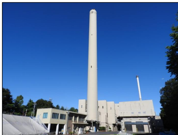
小平・村山・大和衛生組合の外観
