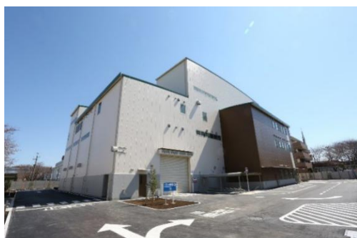
資源物中間処理施設の外観
