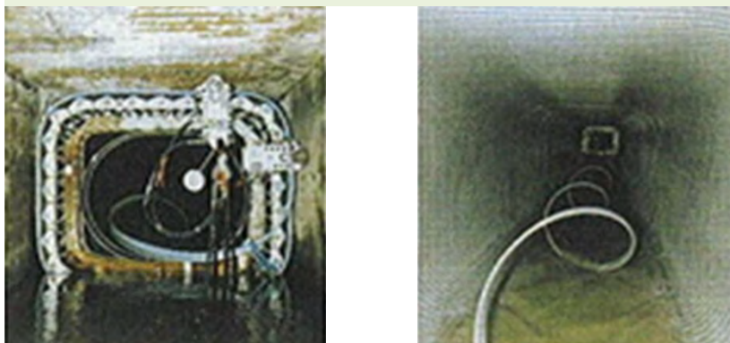
プラスチック材により既設管きよの内面を被覆
