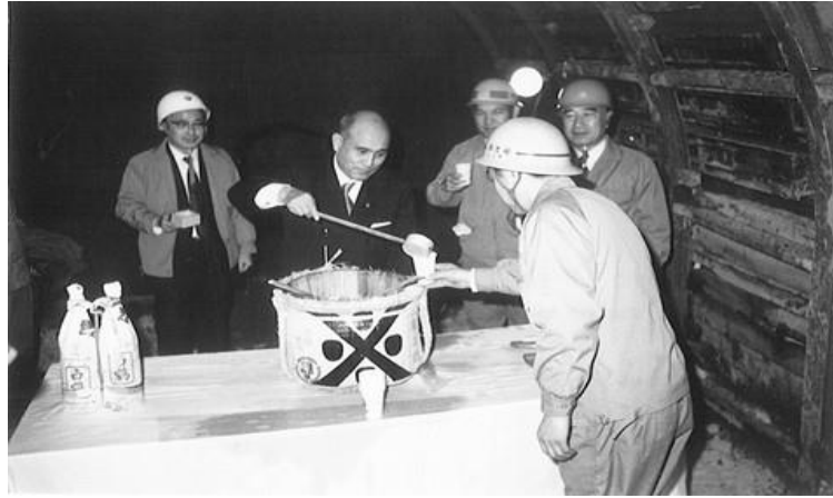
(汚水幹線整備(下水貫通式))
