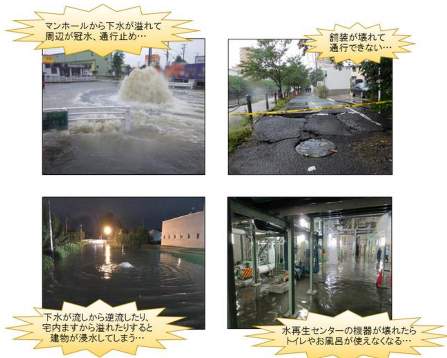
写真 3-9 雨天時浸入水による影響例
