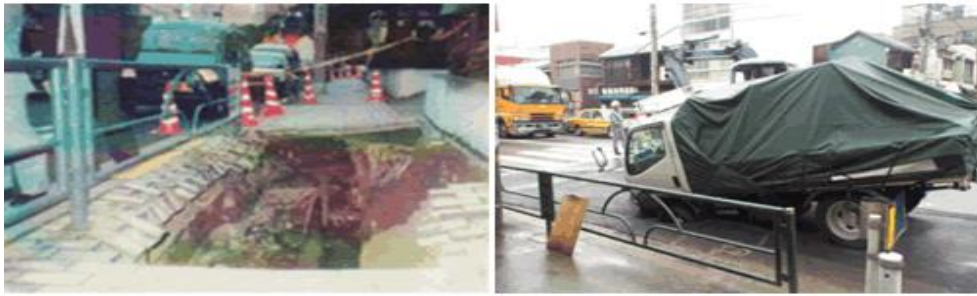
写真3-6 下水道施設に起因した道路陥没状況
