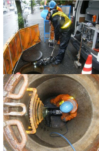
写真 3-7 管きょ内調査の状況
