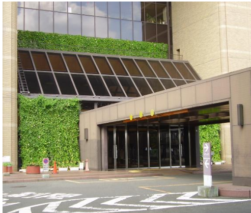
市役所正面玄関の緑のカーテン
