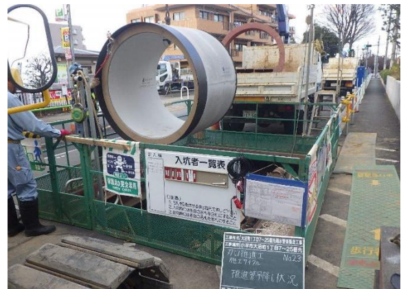
雨水管きょ整備
