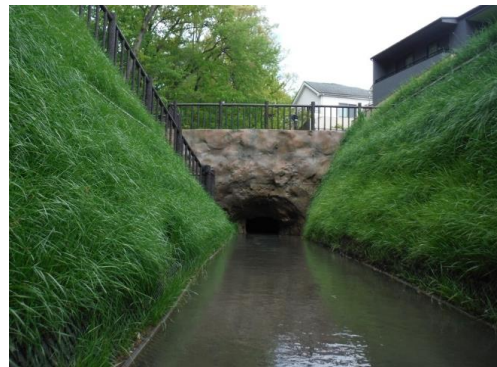
新堀用水のり面(胎内堀)
