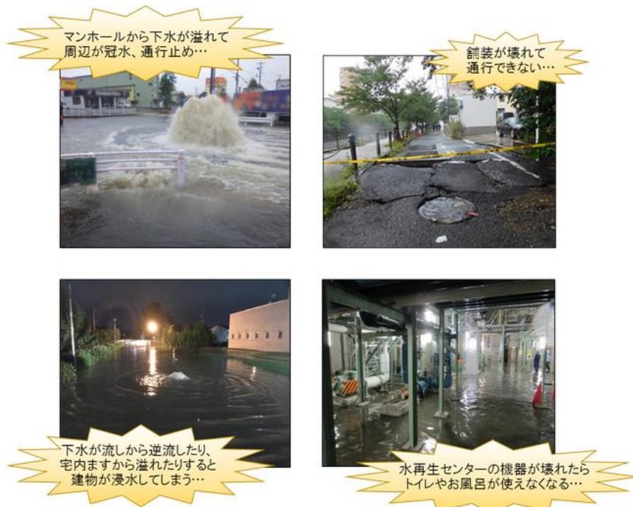
写真 3-9 雨天時浸入水による影響例
