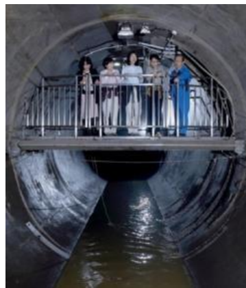
（下水道の見学ステージの様子）
