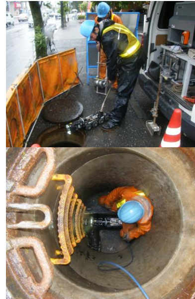
写真 3-7 管きょ内調査の状況
