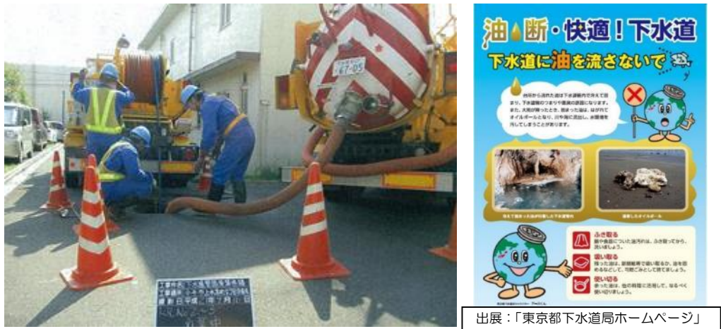
写真 3-5 管きよ清掃状況及びリーフレット
