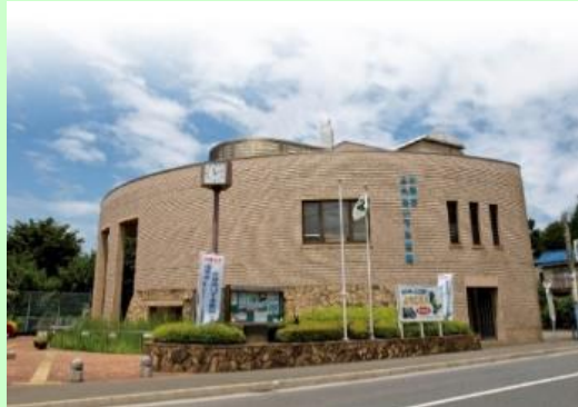
写真：小平市ふれあい下水道館（外観）
