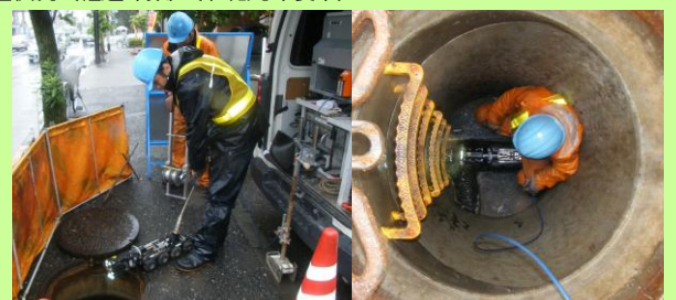
写真：管きよ内テレビカメラ調査の状況
