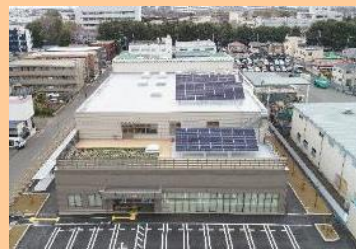
写真:雨水貯留槽を設置した新規公共施設の例
