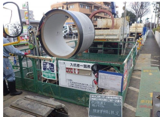
雨水管きょ整備
