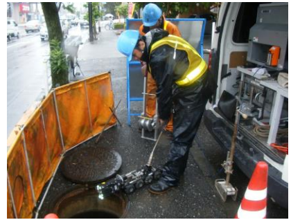
図・写真 管路内テレビカメラ調査のイメージ（管径 800mm 以下）
