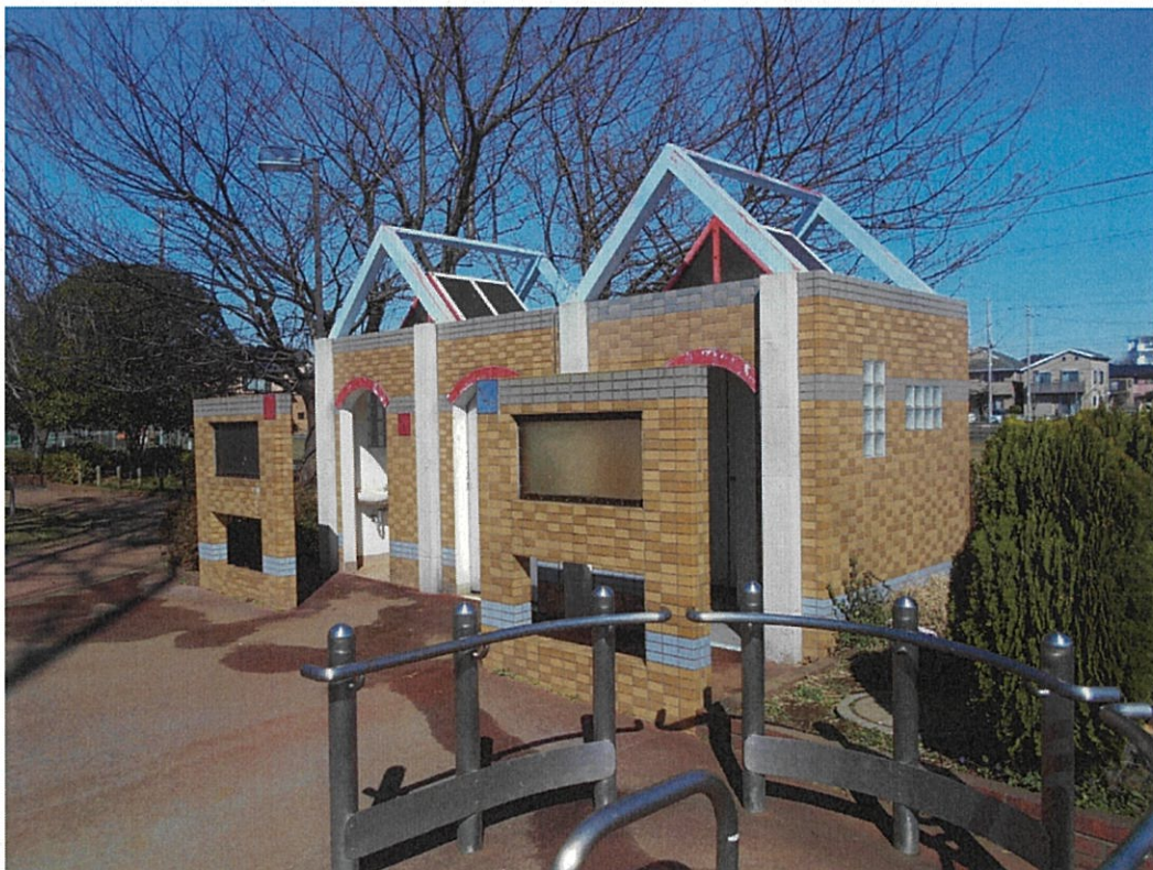
さくら公園の便所棟
