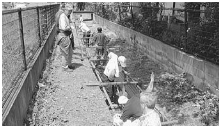
用水路の清掃の様子
