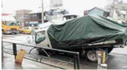
老朽化した下水管が原因の道路陥没（出典・国土交通省ホームページ）
