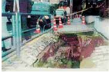
老朽化した下水管が原因の道路陥没（出典・国土交通省ホームページ）
