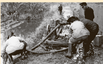
昭和30年ごろ 冠水した道をポンプで排水作業(場所不明) 小平市立図書館所蔵 飯山達雄氏寄贈
