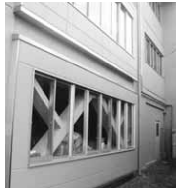
学校の耐震補強
